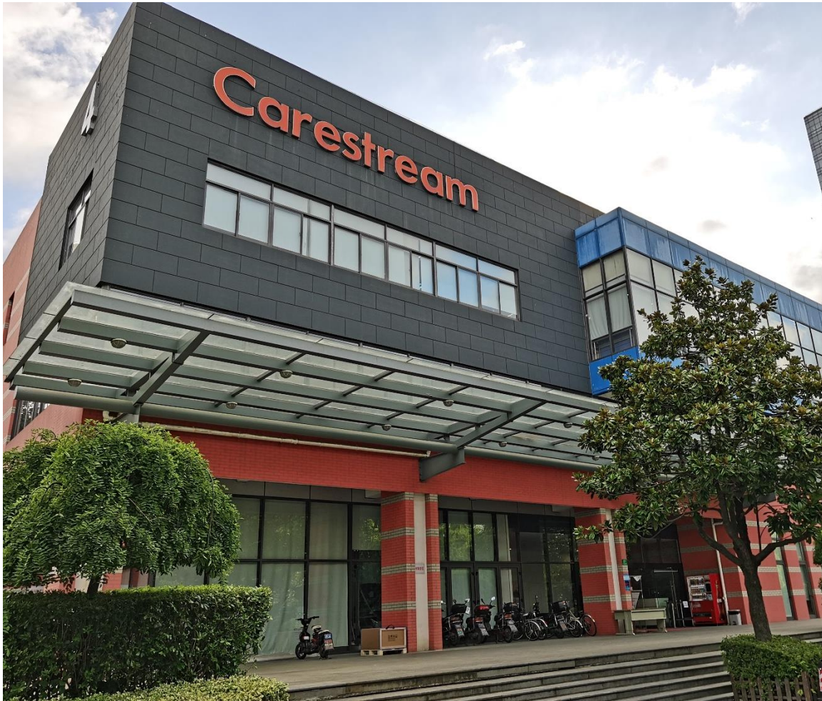
Figure 1 : Le bâtiment de Carestream (source : auteur)
