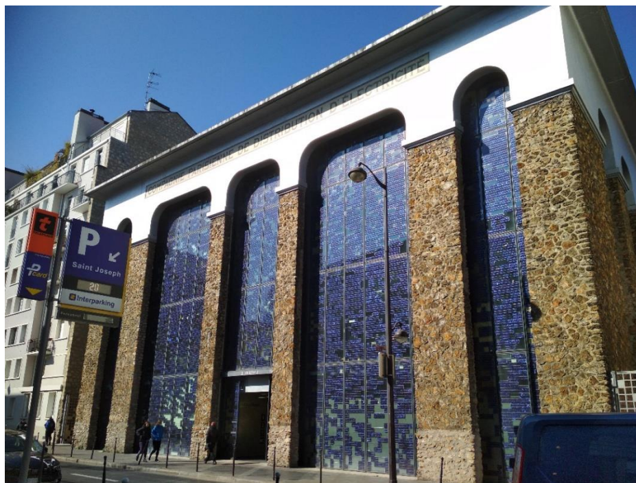
Figure 04 : Compagnie Parisienne de distribution d'électricité (source : auteur)
