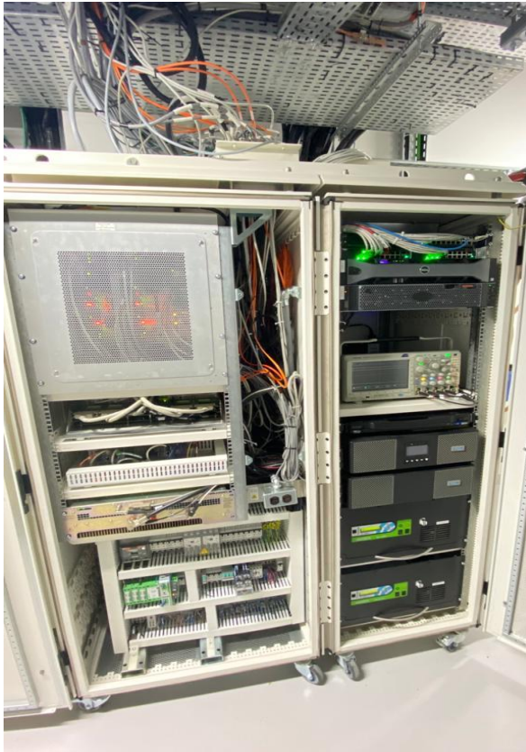
Figure 9: Armoire du circuit de puissance (source auteur) Figure 8: Armoire du circuit de commande (source auteur)
