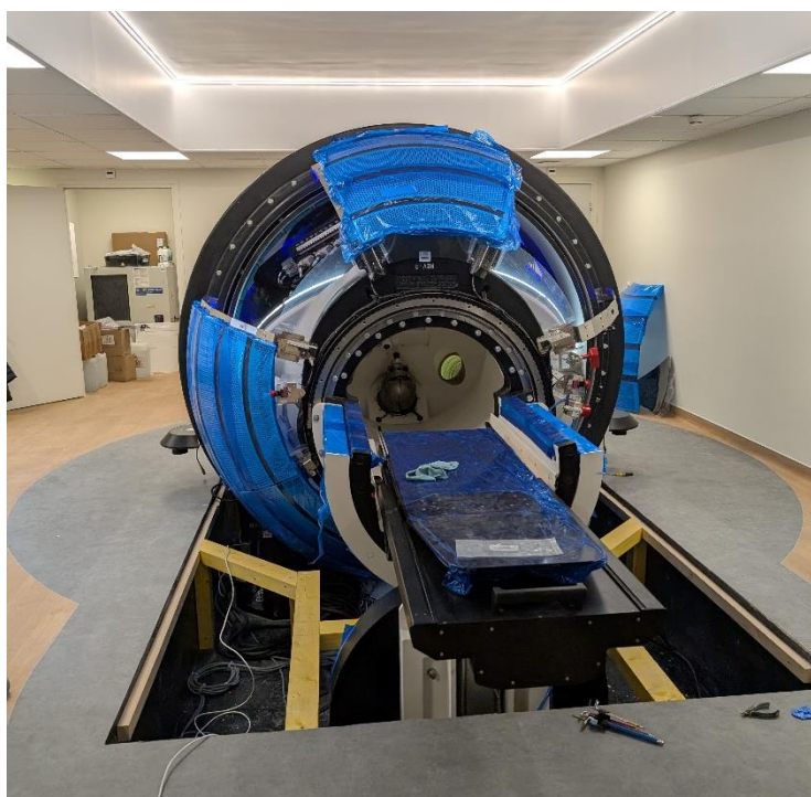
Figure 25 : Zap-X en cours d'installation (source : auteur)
