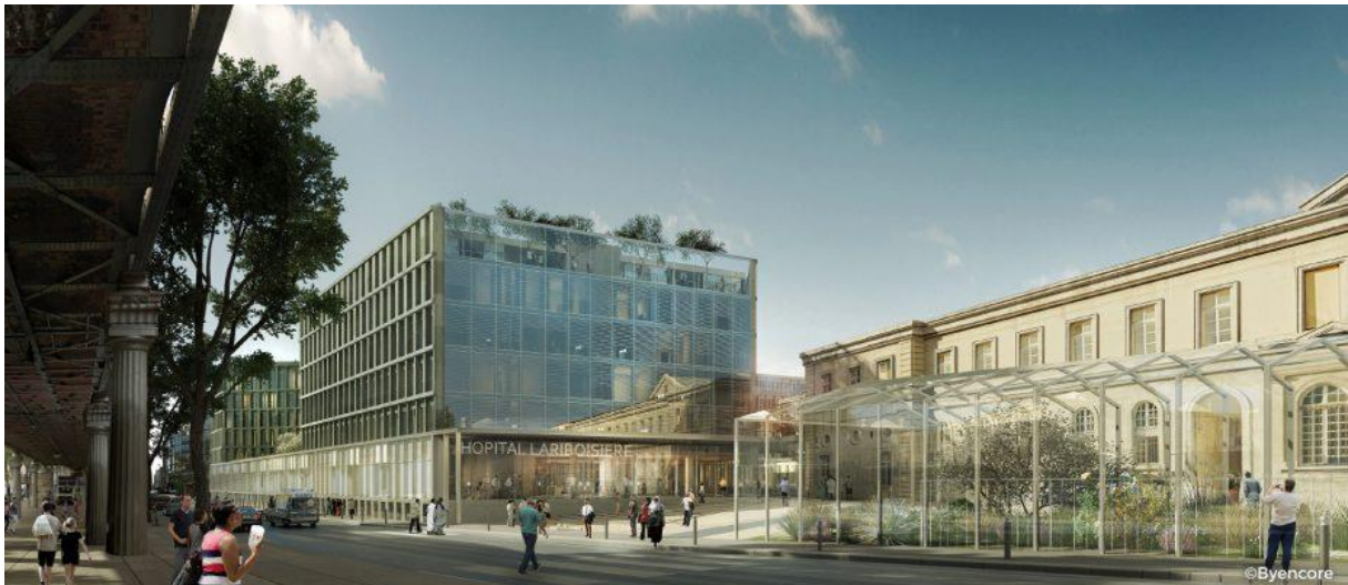
Figure 9 : Future entrée du Nouveau Lariboisière [4]
