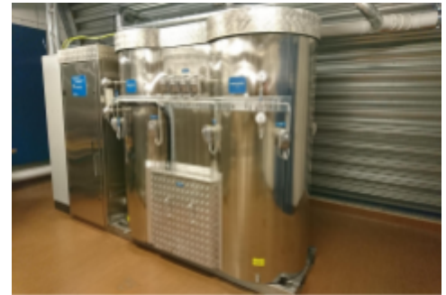
Figure 7: Système centralisé Medicvent Swingtherm (Source : Puramed)
