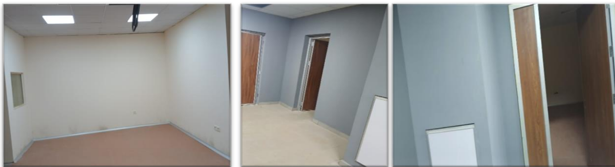
Figure 9 : Locaux du service d'imagerie
