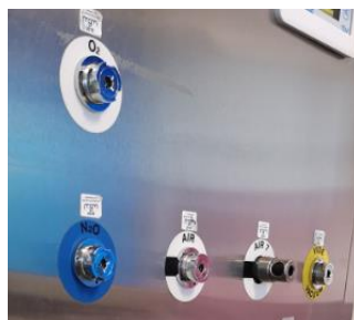
Figure 2 Code couleur des gaz médicaux Source : auteurs
