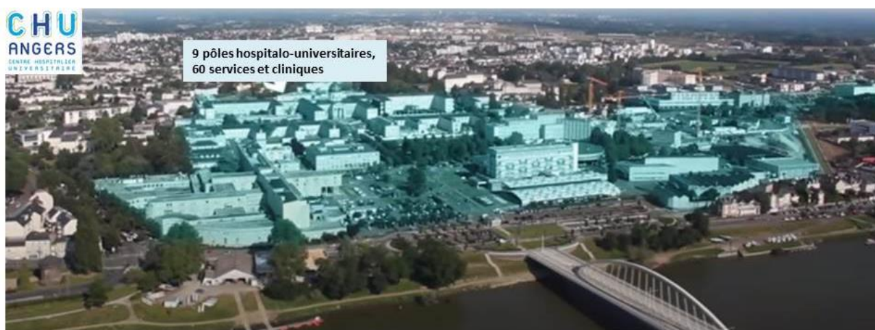
Figure 1 : Le CHU d'Angers, "une ville dans la ville" (source : Morgan View Communication)
